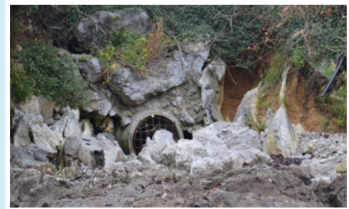
Efluente del tramo B82T1.
